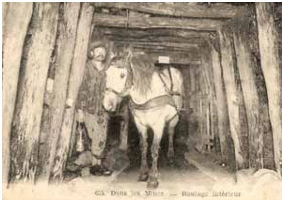
Cheval tractant à l'aide d'une bricole (collier permettant de tirer une charge) Collection particulière
